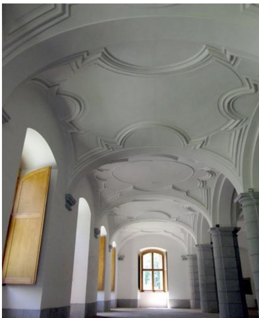
Obrázek 3.24: Zaklenutí chodby kláštera v Plasech několika pruskými klenbami [11].
