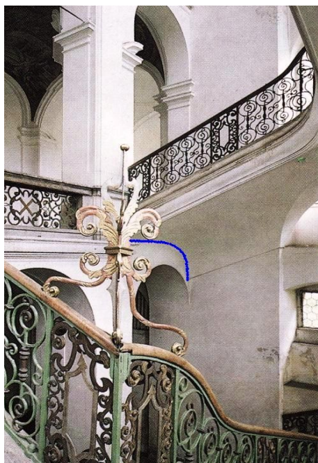
Fotografie 3.1: Hlavní schodiště v klášteře v Plasech: a) modře obecná lícová křivka (převzato z Pousková, M. [16], zadní desky), b) červeně směr valení čelní křivky klenby (převzato z [11]); lícová křivka a směr valení doplněn autorkou.
